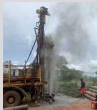
Sierra Leone: Forage d'eau pour un complexe scolaire
