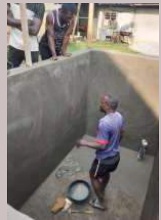
Cameroun: Construction d'une ferme piscicole pour la sécurité alimentaire
