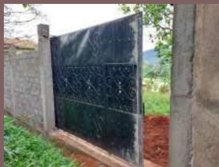
Camerún: Construcción de un muro de contención para el Seminario Mayor San Vicente de Paúl, en Yaundé
