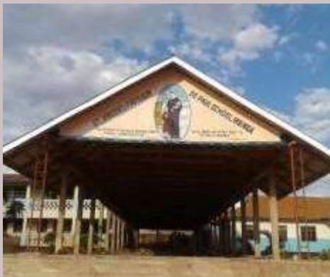
Tanzania: costruzione di un padiglione all'aperto presso la scuola De Paul
