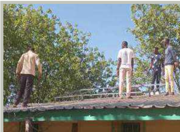
Instalación de los paneles solares en la azotea.
