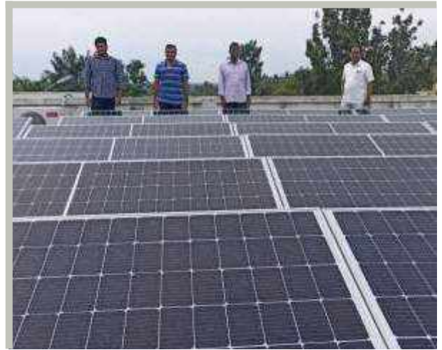
P. Anil Thomas CM, P. Jijo Joseph CM, P. Tabin Mathew CM, y el P. Stephen Antony, CM, de la Provincia India Sur, en el techo de la casa provincial con un nuevo panel de energía solar instalado.
